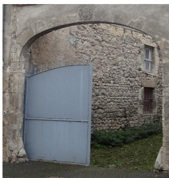
26-28 rue Maréchal Foch
